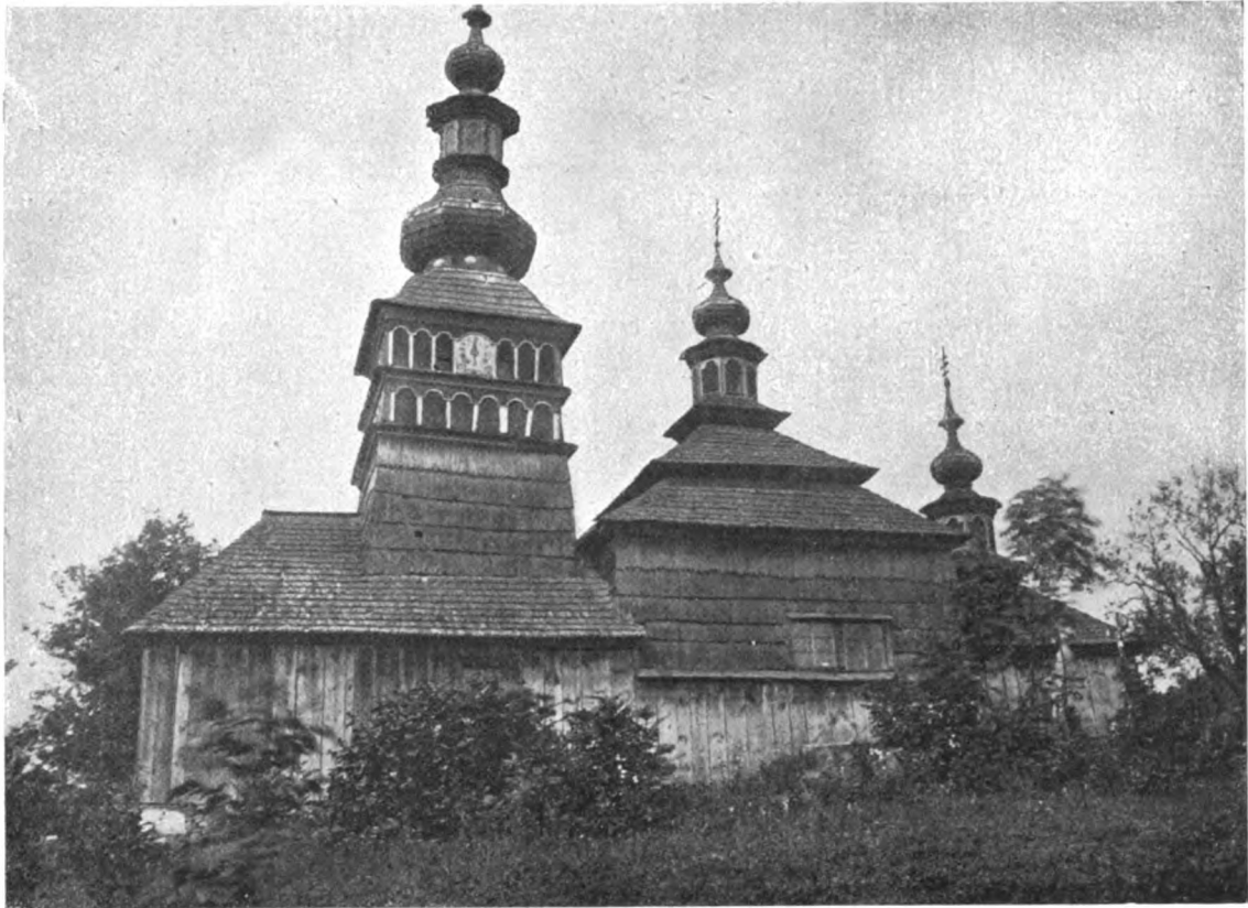
94. SEITENANSICHT DER KIRCHE VON NIKLOWA
