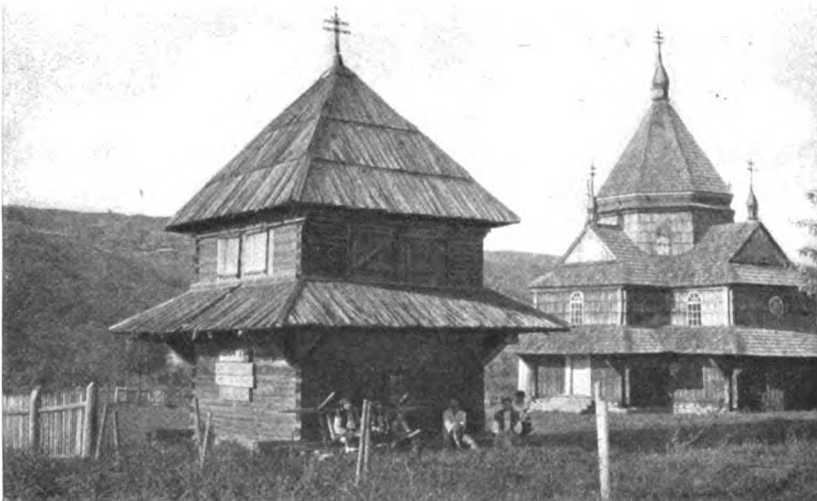
16/17. KIRCHE UND GLOCKENTURM VON JASINIA PLYTOWATE
