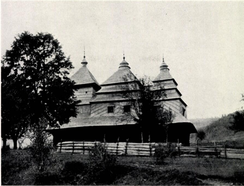
29. VIŠKA (VELKÁ BEREZNA). Fil. řecko-katolická cerkev sv. Michala arch. od jihu.
